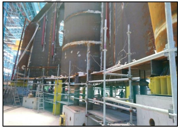
圖 2 變更後 1 米支撐座施工圖
